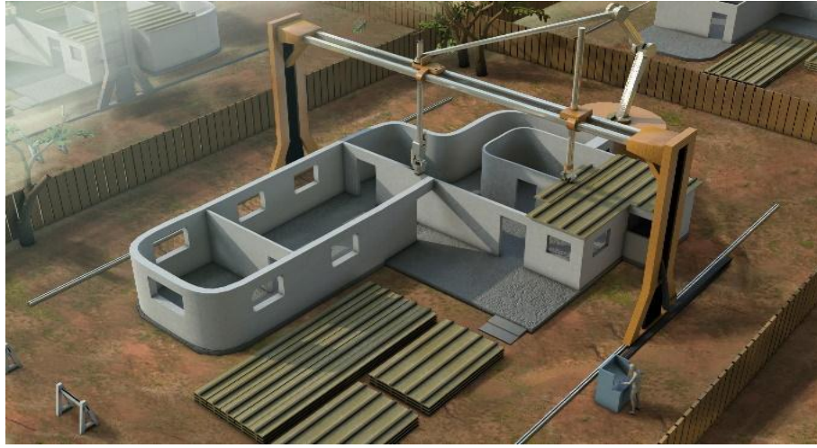
Şekil 3.6. Üç boyutlu beton yazıcı ile birkaç işçi kullanılarak bina yapımı (Fernandes ve Feitosa, 2015).
