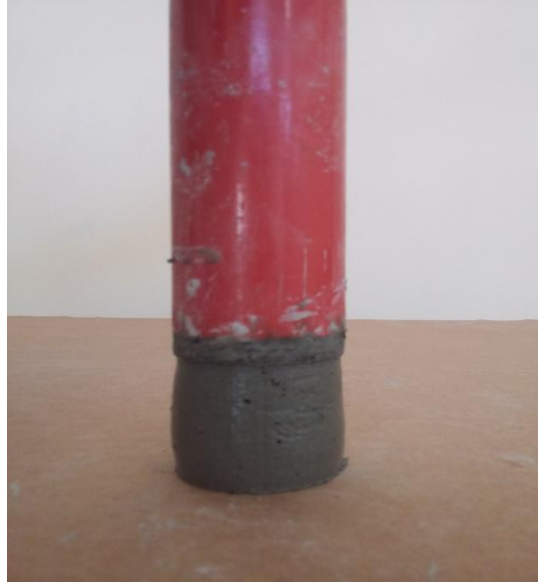
Şekil 6.3. Beton harcın pompa ağzından çıkış görüntüsü.
