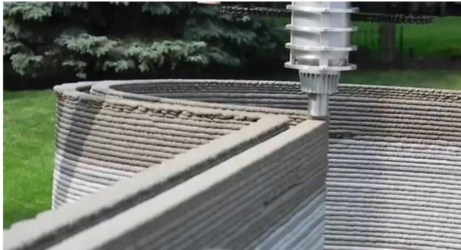
Şekil 3.4. Üç boyutlu beton yazıcı ile beton baskı (totalkustom, 2016).
