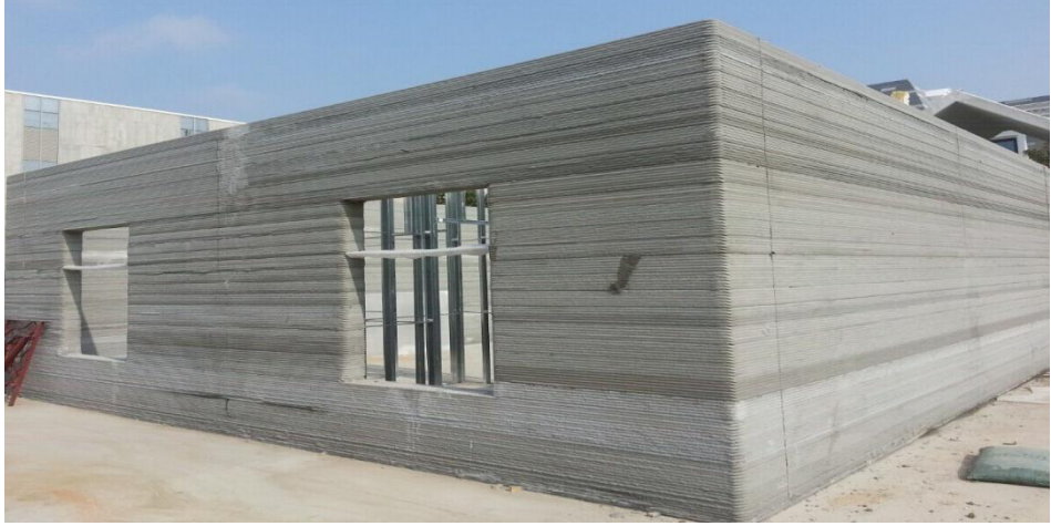
Şekil 2.4. Win Sun Şti. 3 boyutlu beton yazıcı kullanılarak yapılan örnek ev (yhb, 2016).
