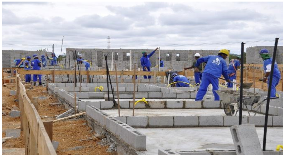
Şekil 3.5. Geleneksel inşaat yöntemlerinde işçi kullanımı (Fernandes ve Feitosa, 2015).
